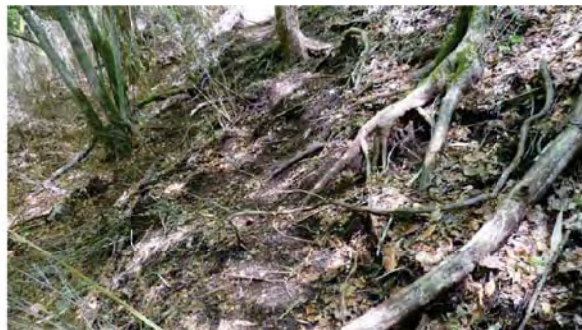
(2014/5/24 雨後、ズリ落ち部、迂回路とも侵食進む)
