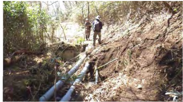
(2013/4/28 通過後 登山道崩落し左側を通行)
