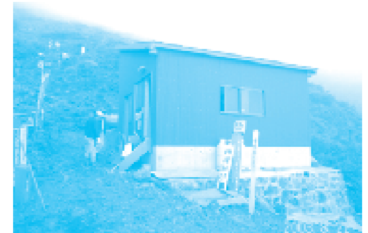
平成15年度新たに整備されたトイレ
